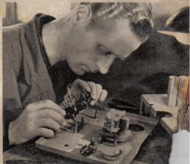
Einsetzen des Spulensatzes mit Spulenschalter auf den Prüfapparat. Die Spulen sind mit Speziallack gehärtet und sind genau gealtert. Links: Eichen des Prüfsenders. Das linke Instrument gestattet Eichungen von 0,1%, die Sendertoleranz
